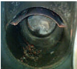
**Chambre de combustion d'une chaudière avec présence de dépôts dus à la combustion de mazout Euro**
