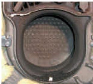
**Chambre de combustion propre grâce à l'utilisation de mazout Eco pauvre en soufre**
